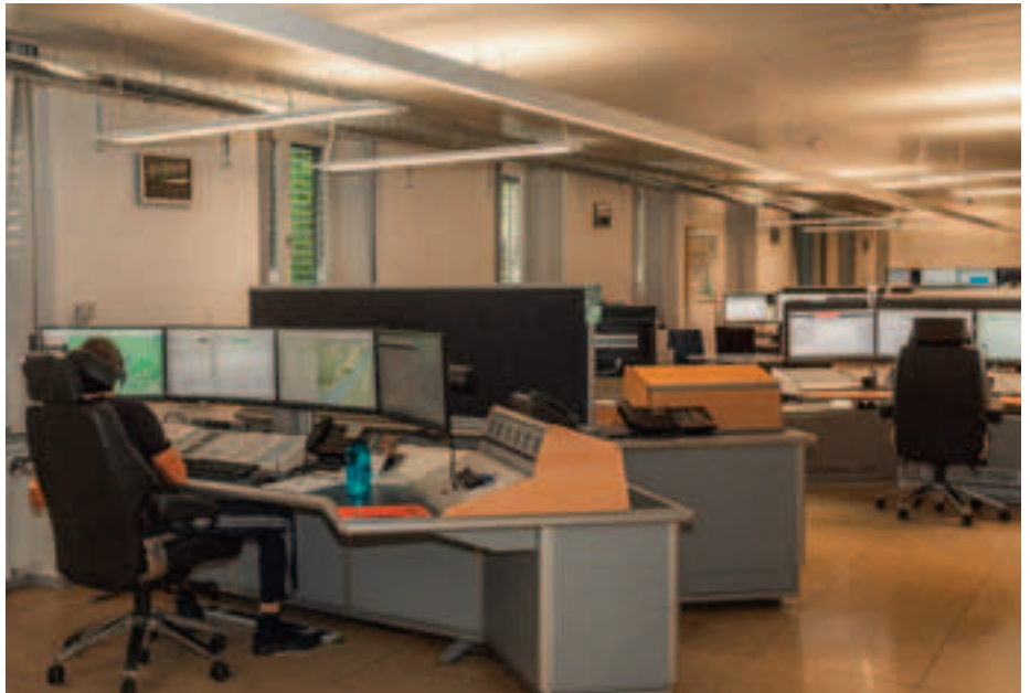
Die Räumlichkeiten der Landesleitzentrale in der Kaiserjägerstraße 8 in Innsbruck.
